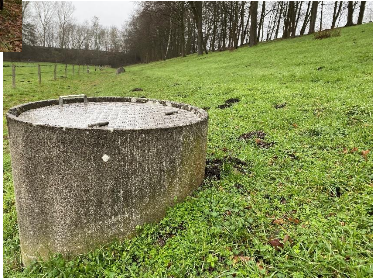
Fotos oben: Zufahrt zum Betriebsweg am Mittellandkanal und bautechnische Anlagen südlich des Mittellandkanals im Gebiet der Stadt Minden
